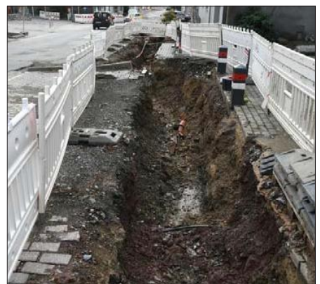
Die Versorgerleitungen werden verlegt.
