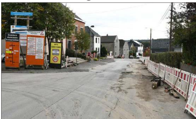
Im Zentrum von Raeren ist noch kein Ende der Arbeiten in Sicht.
